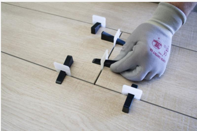
Se desaconseja la colocación a junta trabada mayor del 25% para evitar la aparición de cejas. No se aceptarán reclamaciones de material colocado a junta trabada mayor del 25%
